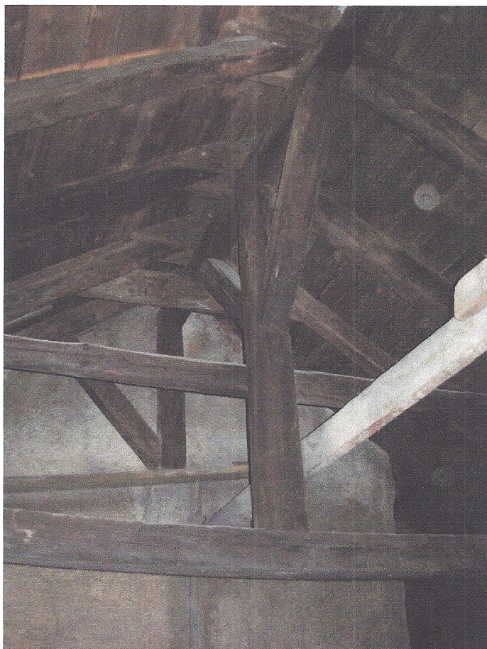
Węzeł podporowy płatwi kalenicowej na ścianie stolcowej.
