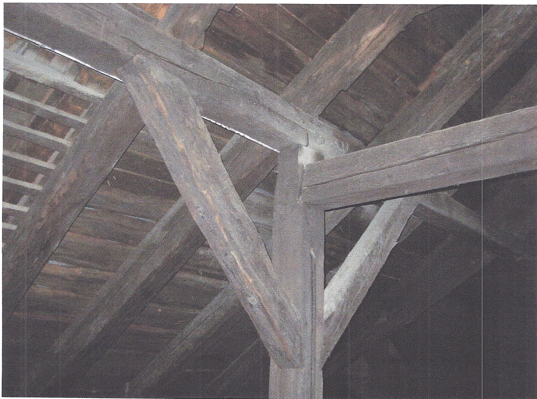
Węzeł podporowy krokwi na ścianie stolcowej.
