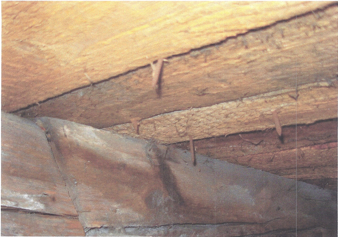
Stosowana wcześniej technika mocowania pokrycia z blachy.
