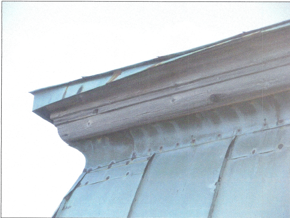
Szczegół drewnianego gzymsu pod okapem górnej części mansardy.
