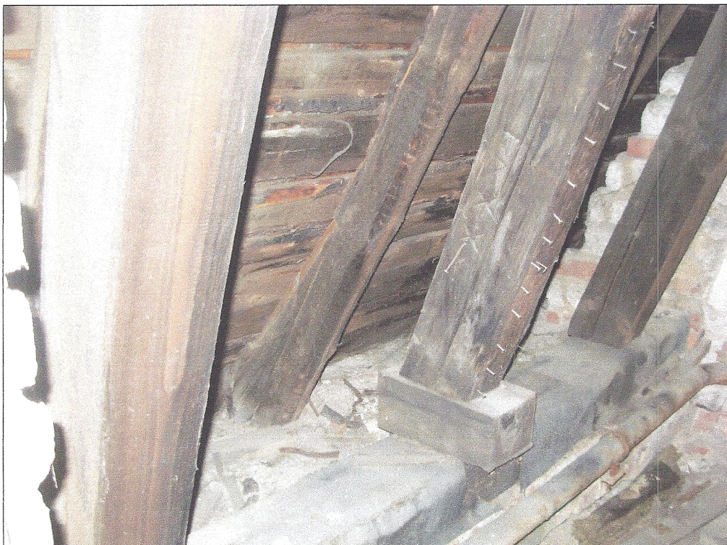
Oparcie na ścianie dolnej części mansardy.
