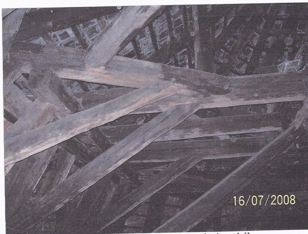
Elementy konstrukcyjne więźby
