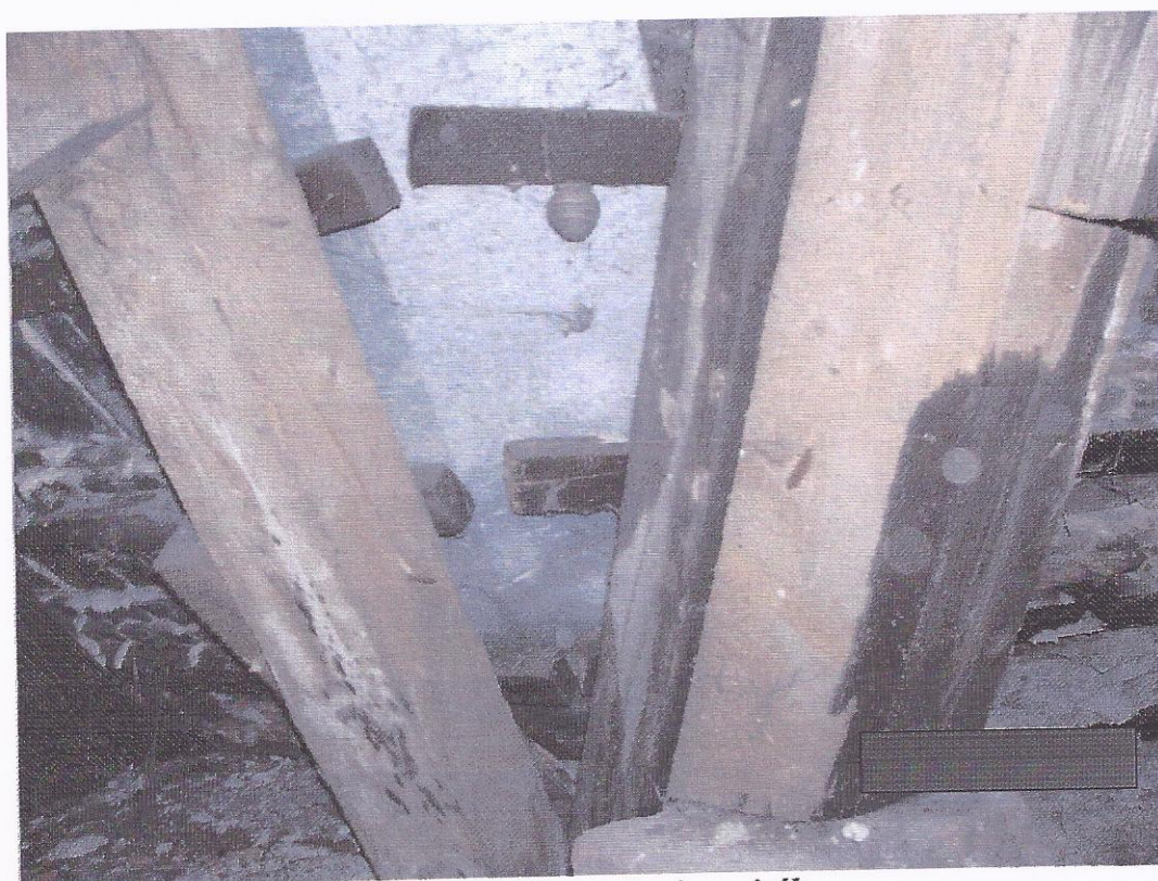
Elementy konstrukcyjne wieży
