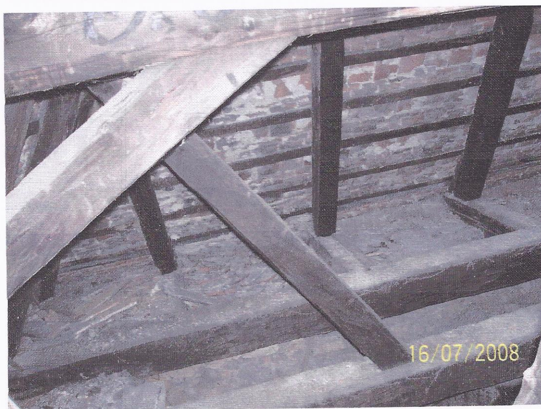
Elementy konstrukcyjne wieży
