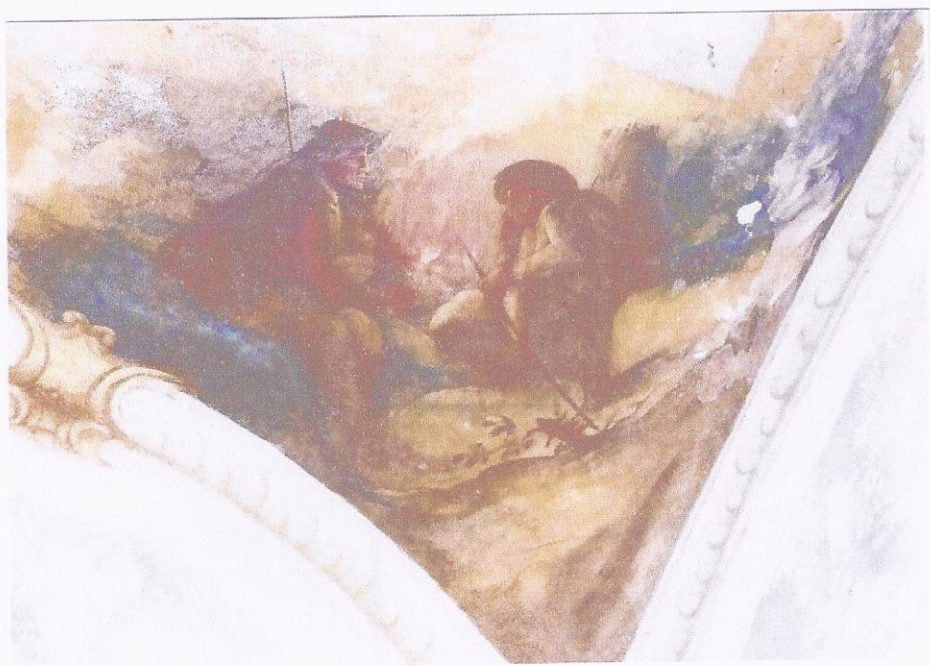
Fot. 12. Ujęcie fragmentu sklepienia południowego ryzalitu. Widoczna przedstawiona scena rodzajowa z pasterzami siedzącymi przy ognisku. Widoczne niewielkie ubytki tynku i polichromii
