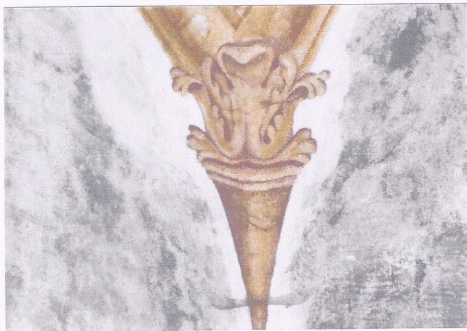
Fot. 10. Ujęcie fragmentu XVIII-wiecznej polichromii w ryzalicie. Zdjęcie zwornika w narożniku malowanego gzymsu. Widoczny stan zachowania malatury ścian.
