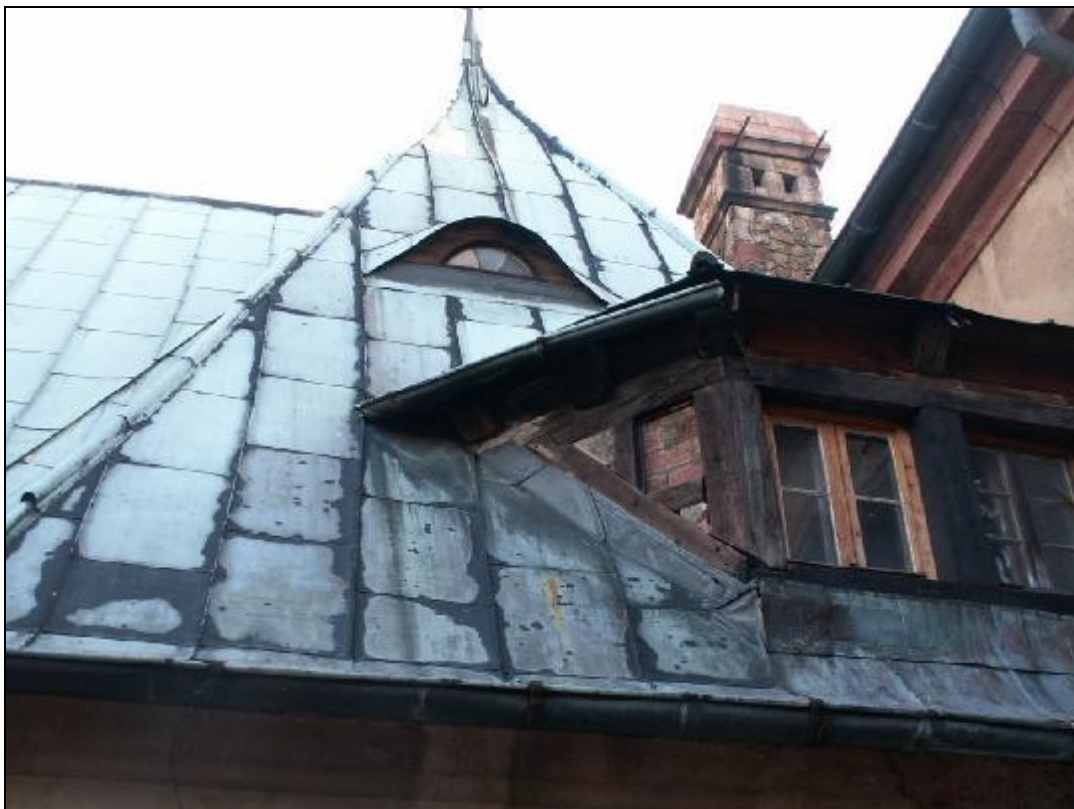
LUKARNA SZCZYTU POŁACIOWEGO PÓŁNOCNEJ STRONY SKRZYDŁA ŚRODKOWEGO
