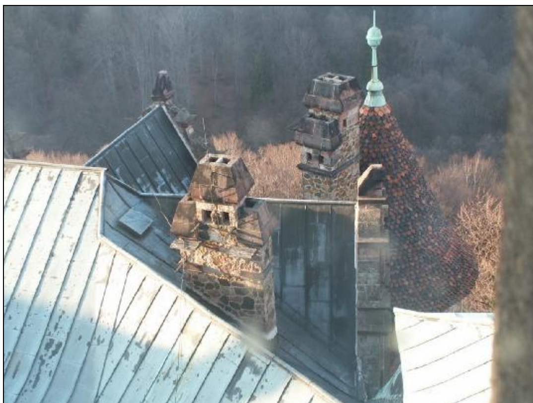
KOMINY PRZY MAŁEJ WIEŻY – SKRZYDŁO PÓŁNOCNE
