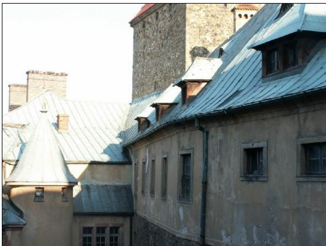
ŚCIANA PÓŁNOCNA SKRZYDŁA ŚRODKOWEGO
