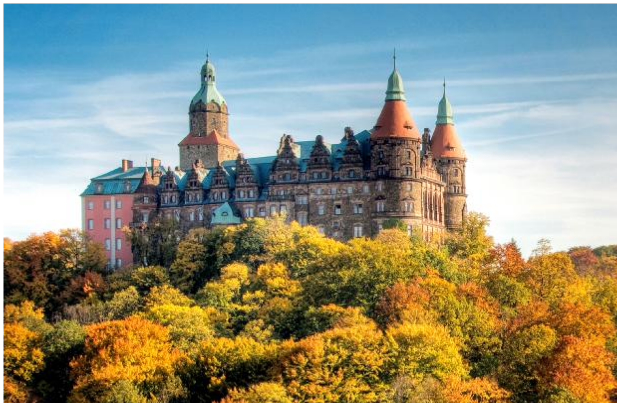
STRONA PÓŁNOCNA SKRZYDŁA PÓŁNOCNEGO – WIDOCZNY WYKUSZ (fot. Kamil Cieliński)
