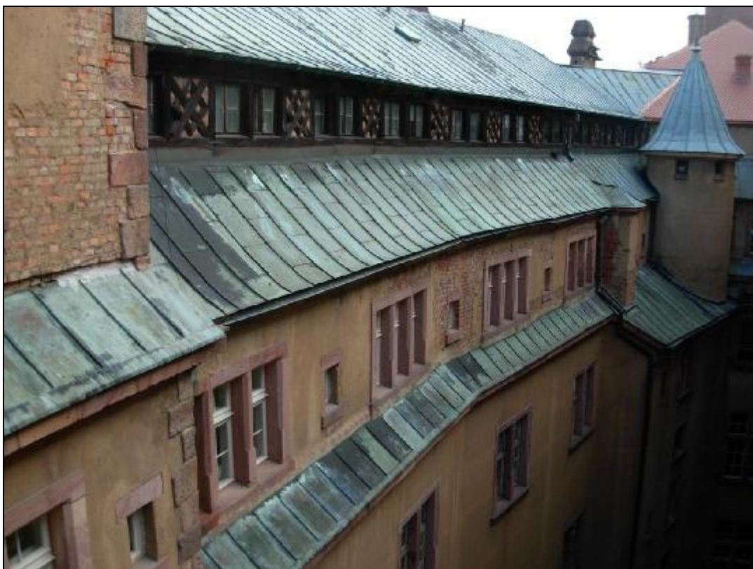
ŚCIANA POŁUDNIOWA SKRZYDŁA PÓŁNOCNEGO
