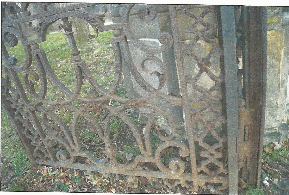
Fot.11 Dolna kwatera skrzydła zachodniego.
