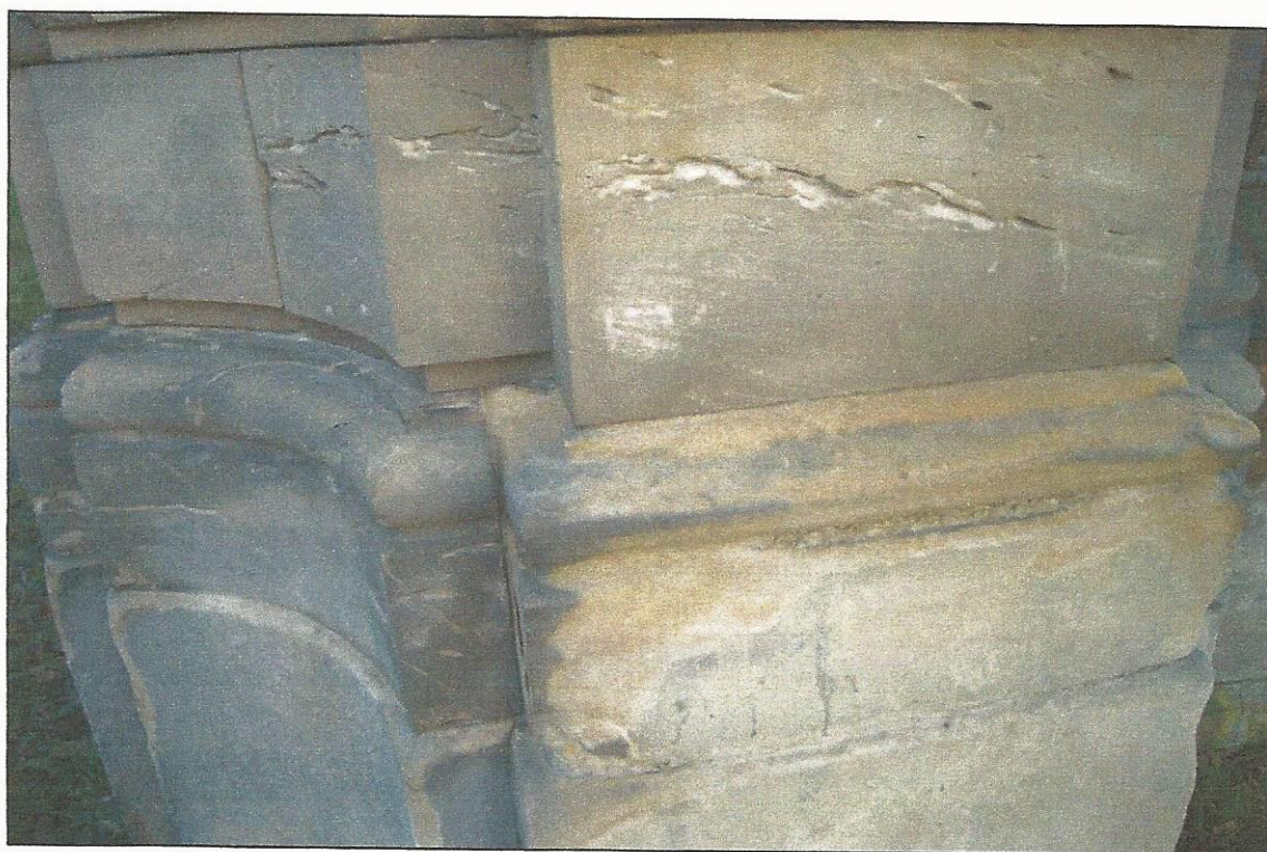
Fot.4 Stan przed konserwacją . Fragment ośmiobocznego filara.
