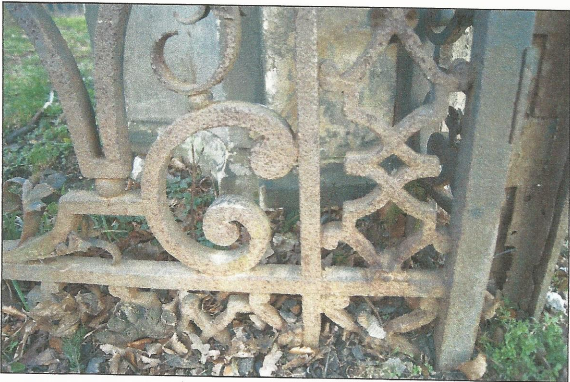
Fot.14 Stan przed konserwacją .Fragment uszkodzeń przy zawiasach dolnej kwatery.
