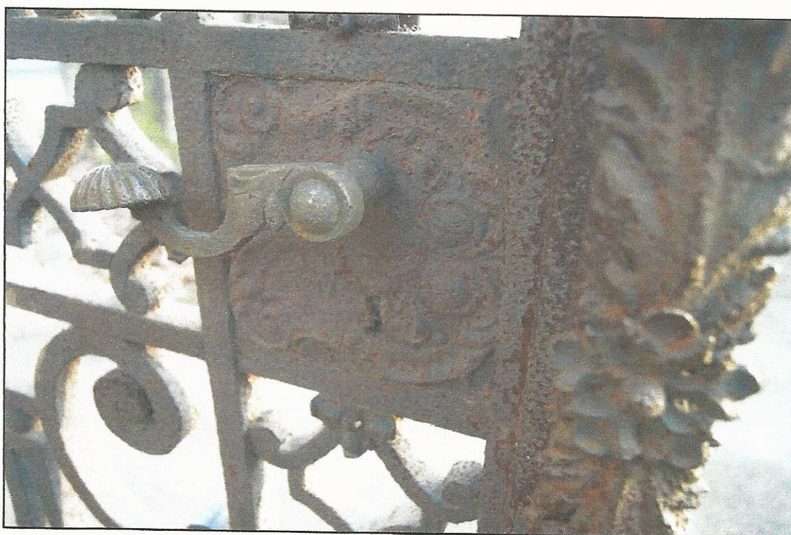
Fot. 17 Stan przed konserwacją. Szyld zamka z klamką.
