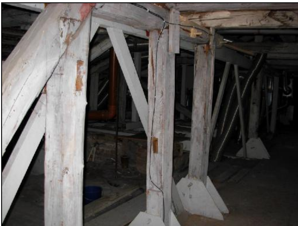
ŚCIANA STOLCOWA DACHU CZĘŚCI ŚRODKOWEJ
