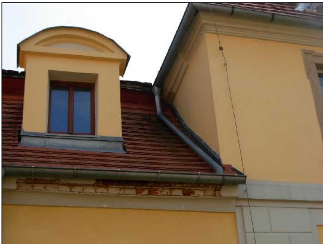
GZYMS OKAPOWY CZĘŚCI ŚRODKOWEJ DACHU
