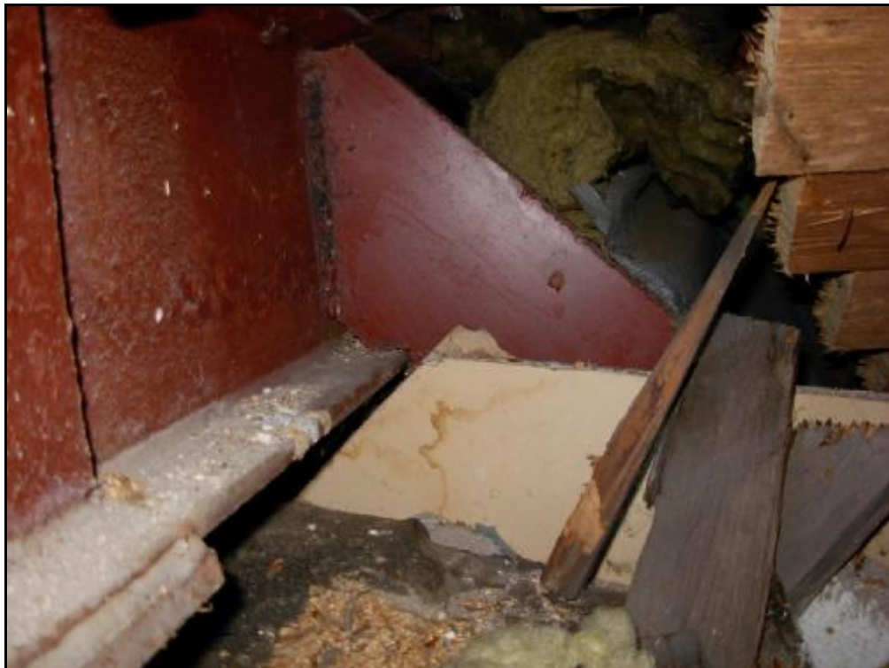
OPARCIE GÓRNEGO KOŃCA KROKWI MANSARDY NA BELCE STALOWEJ
