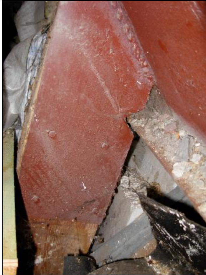
OPARCIE GÓRNEGO KOŃCA KROKWI MANSARDY NA BELCE STALOWEJ
