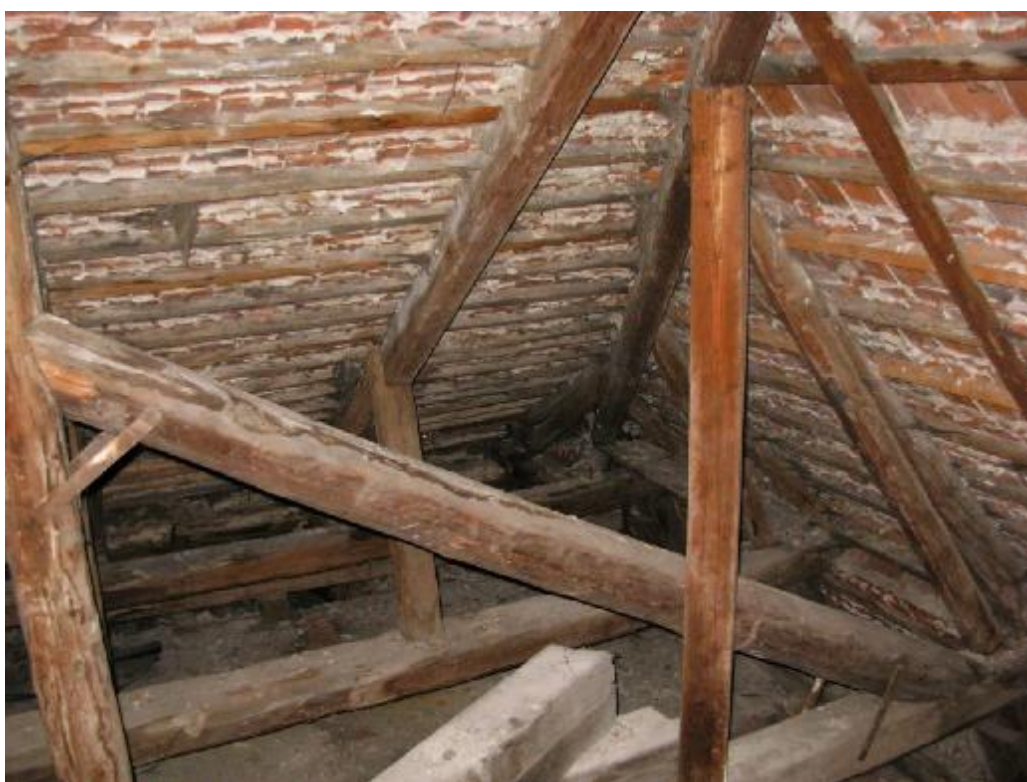
KONSTRUKCJA DACHU CZĘŚCI WYŻSZYCH – KONSTRUKCJA GRZBIETU
