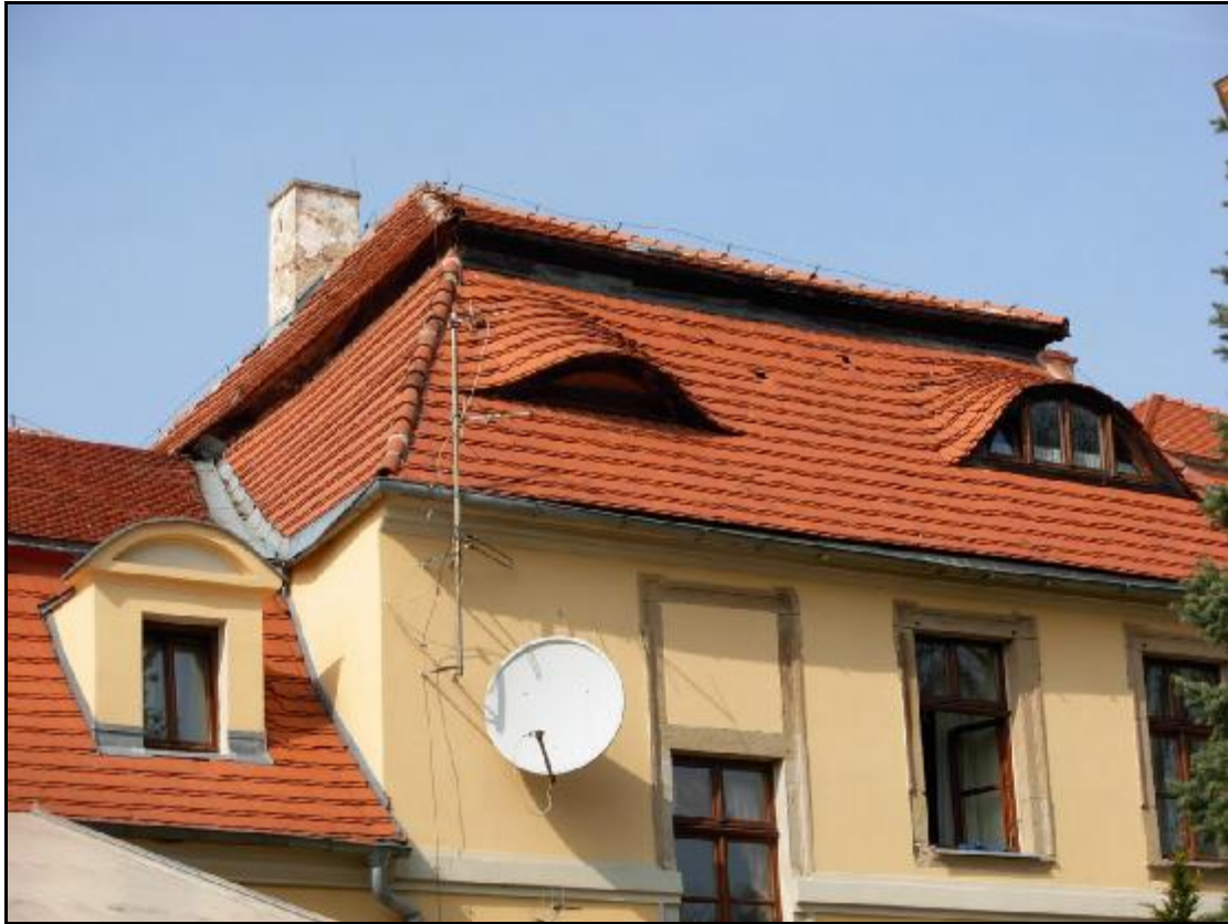
POKRYCIE DACHU CZĘŚCI WYŻSZEJ DACHU – STRONA WSCHODNIA
