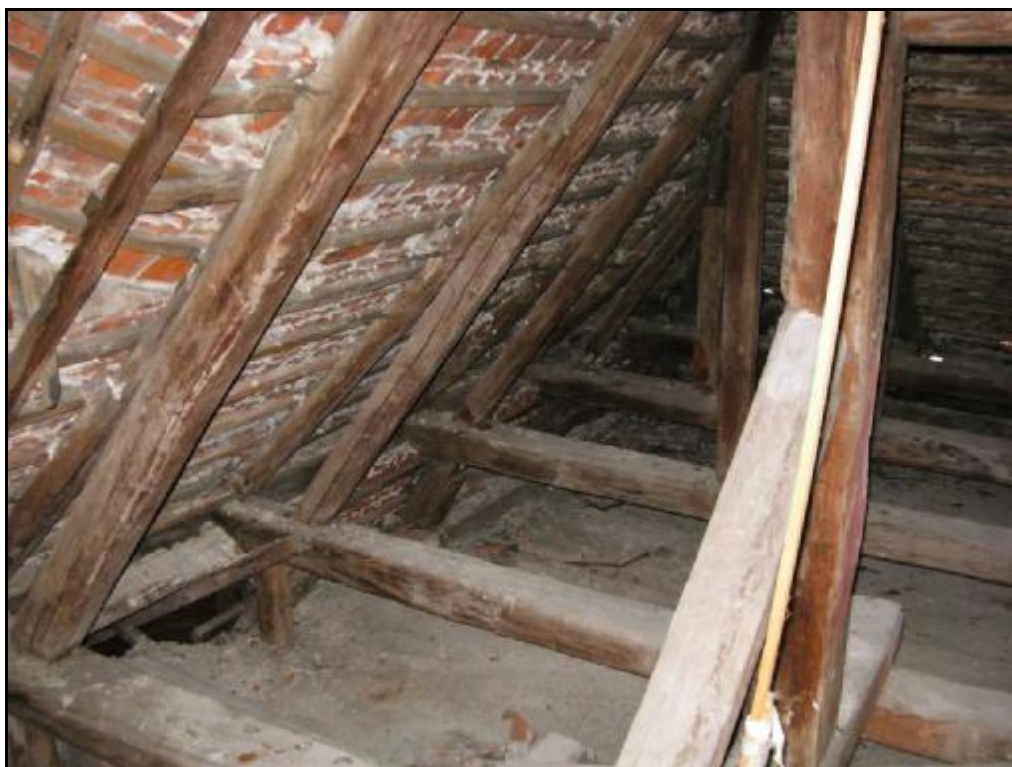
KONSTRUKCJA DACHU CZĘŚCI WYŻSZYCH – WĘZŁY PODPOROWE
