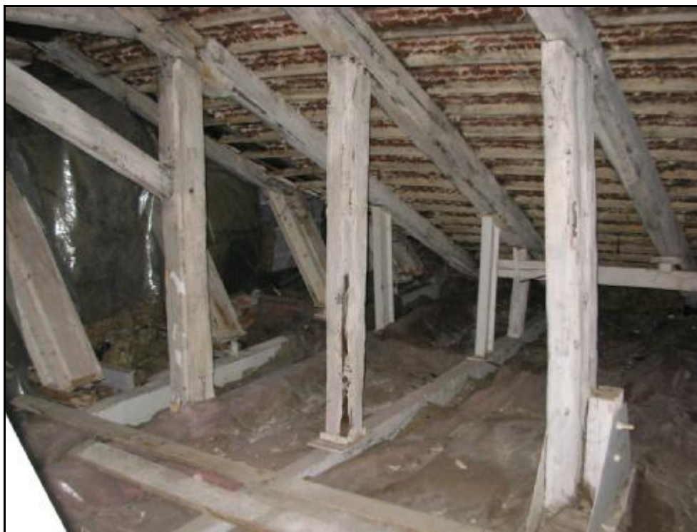
KONSTRUKCJA WIĘZBY DACHOWEJ CZĘŚCI ŚRODKOWEJ
