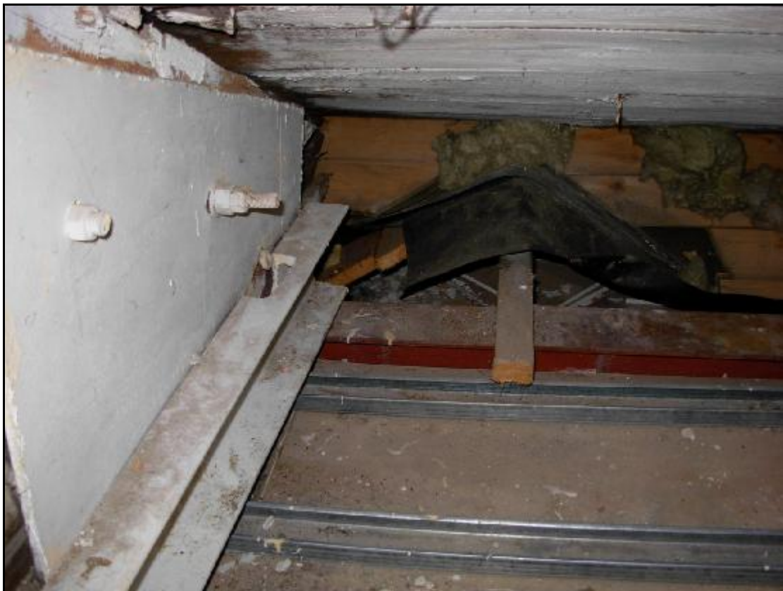
STALOWA BELKA PODPOROWA WIĄZARÓW DACHU CZĘŚCI ŚRODKOWEJ
