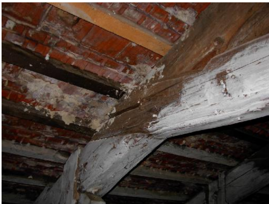
POŁĄCZENIE JĘTKI Z KROKWIĄ – CZĘŚĆ ŚRODKOWA DACHU
