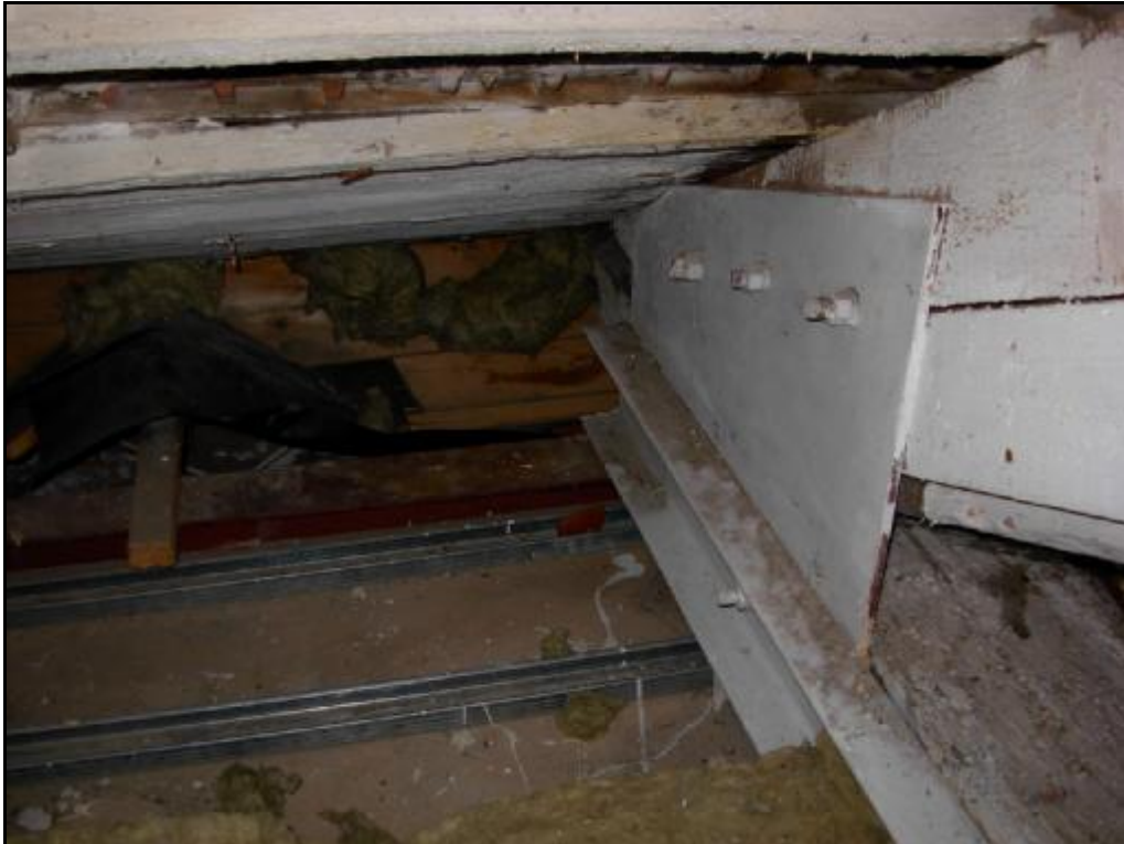
WĘZEŁ PODPOROWY WIAŻARA – CZĘŚĆ ŚRODKOWA DACHU
