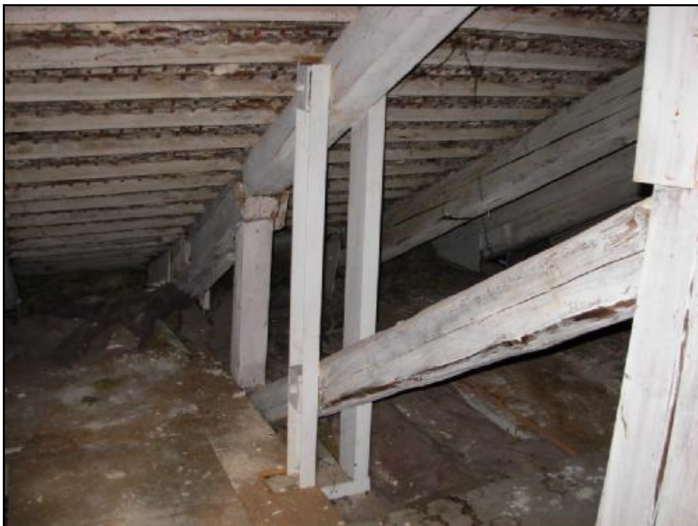
WIAŻAR PEŁNY – CZĘŚĆ ŚRODKOWA DACHU
